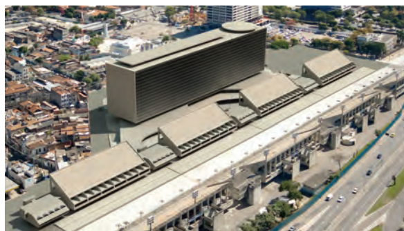
Ali serão construídos módulos semelhantes aos dos setores ímpares e a Ambev erguerá um prédio
